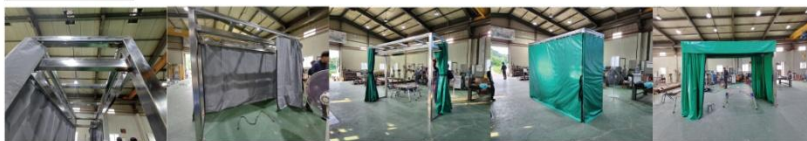
공급진행순서 -- 1) 화재 확산방지용 방화원단 프레임설계 2) 프레임제작 및 설치 3) 방화원단 날개 및 상부덮개 부착
